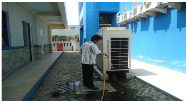
Proses Pembersihan AC bagian Luar
