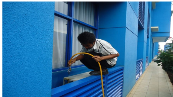
Proses Pembersihan AC bagian Luar
